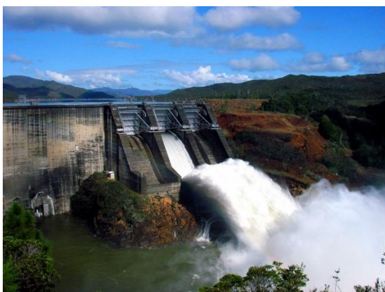
Centrale hydroélectrique de Nangbeto (Togo)
