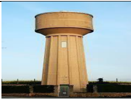
36.â Le château d'eau
