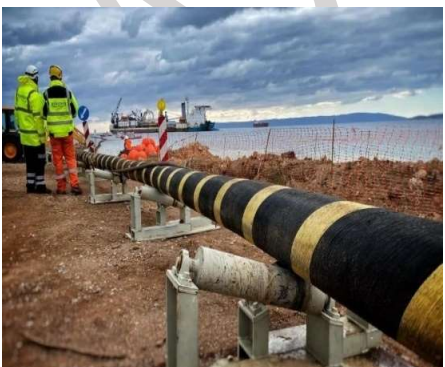
INSTALLATION DE LA FIBRE OPTIQUE
