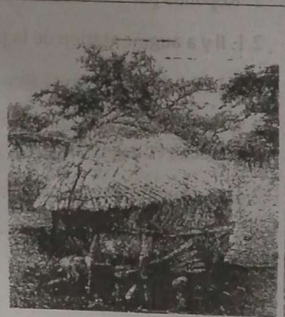
Document 2 : Grenier en paille tressée posé sur de grosses pierres
