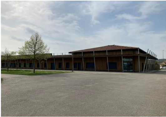
Doc 2 : Construction du centre de loisir
